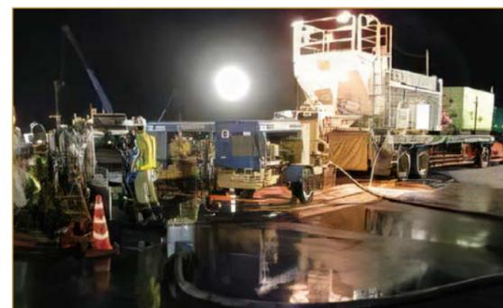
車載型 CPG プラントによる施工状況
