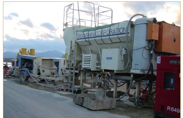
(注入工) 施工機械全景
