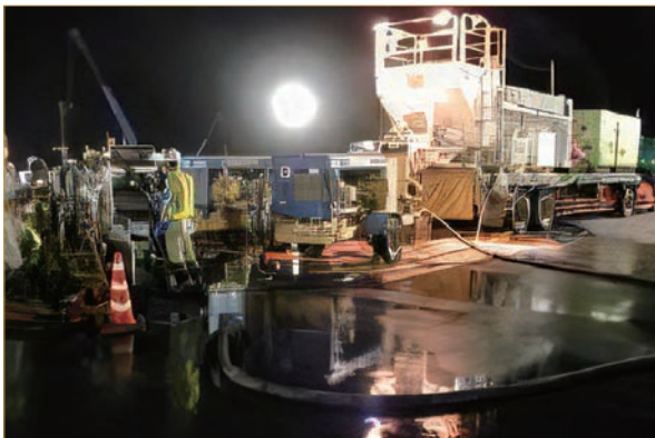
車載型 CPG プラントによる施工状況
