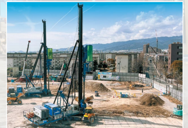
建築基礎工事
