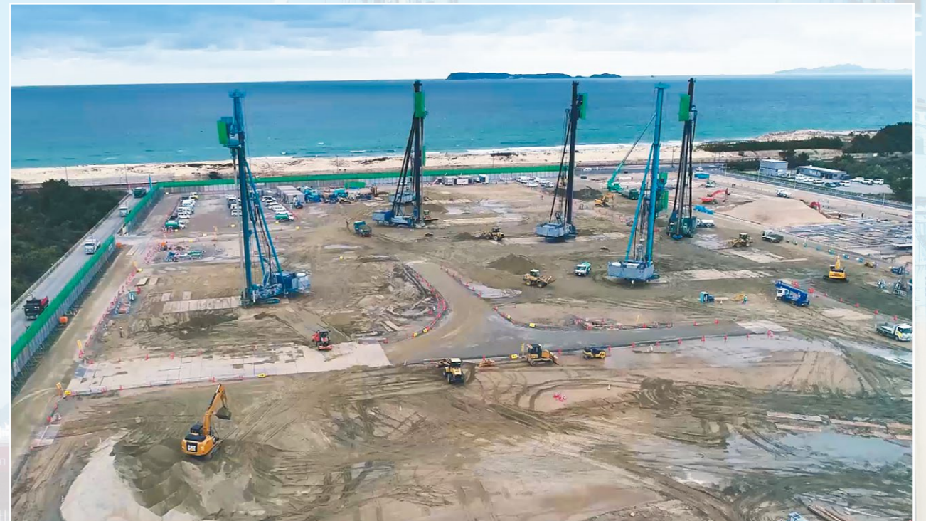
空港施設基礎工事
