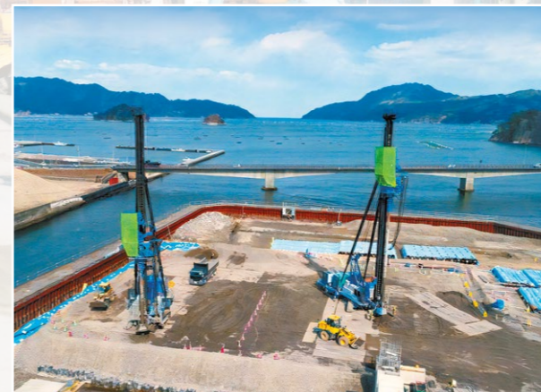
河川堤防基礎工事
